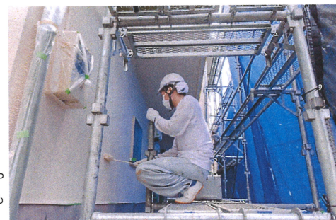
戸建住宅の外壁塗装や屋根塗装の受注実績も豊富です。
