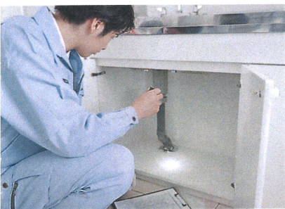
露出配管の水漏れも触診・目視チェックで入念に点検。不具合箇所の早期発見につなげます。
